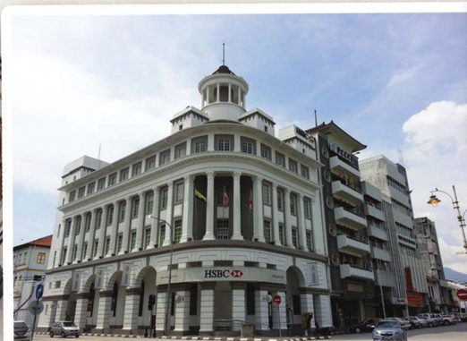
汇丰银行大厦建于1931年，座落在怡保旧街场，是怡保20世纪初的历史建筑物之一，其英式维多利亚风格建筑结构和设计堪称经典。
